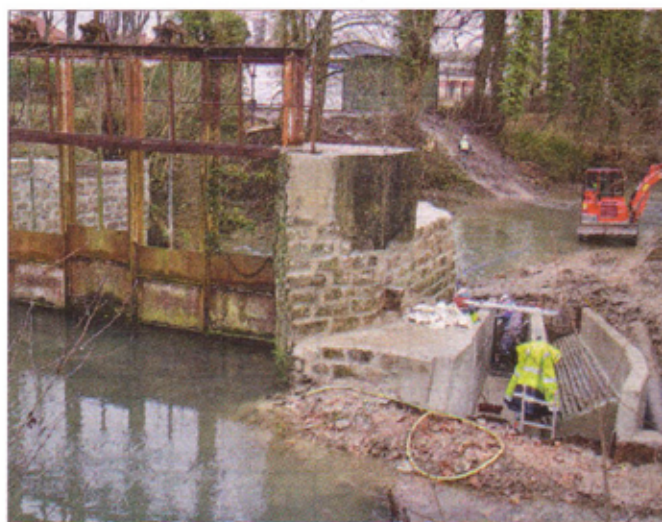
▲ Le chantier hesdinois a débuté par la création d'une passe à poissons.
